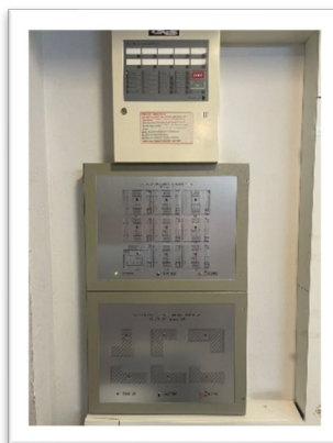
แผงควบคุม Fire Alarm
